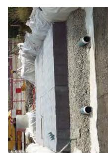
► Pose de blocs alvéolaires (structures non visibles et non curables)
