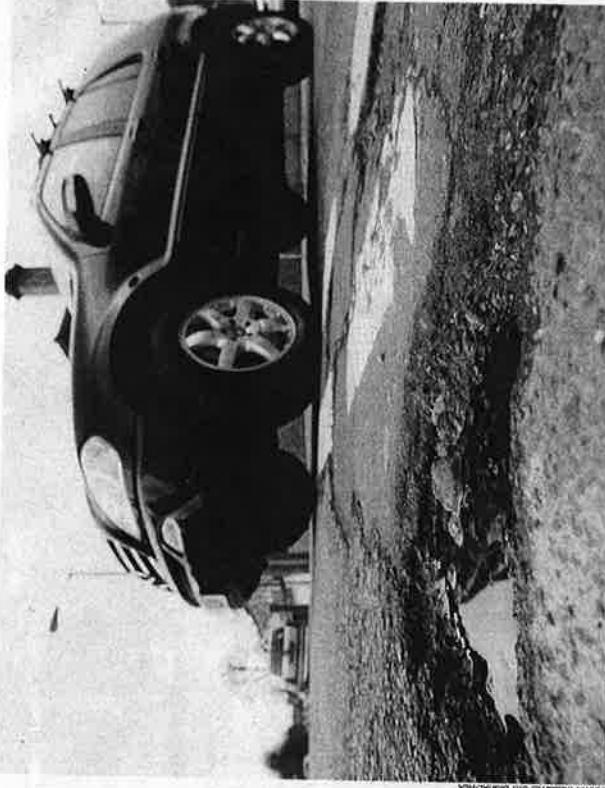
Ci-dessus: vieillissantes, les chaussées ont vu de nombreux nids-de-poule apparaître à leur surface au cours de l'hiver dernier. Un phénomène accentué par la multiplication des cycles gel/dégel.
